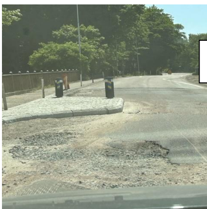
Bild från nyanläggning i Hjälmskult
